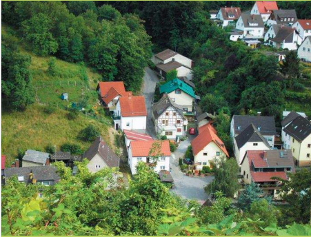
Dachlandschaft in Unter-Hambach
